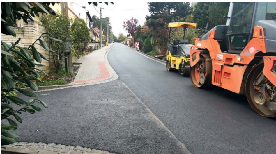
Místní komunikace a chodník v části Drahy se letos dočkaly rekonstrukce. Bude hotovo do konce roku.
