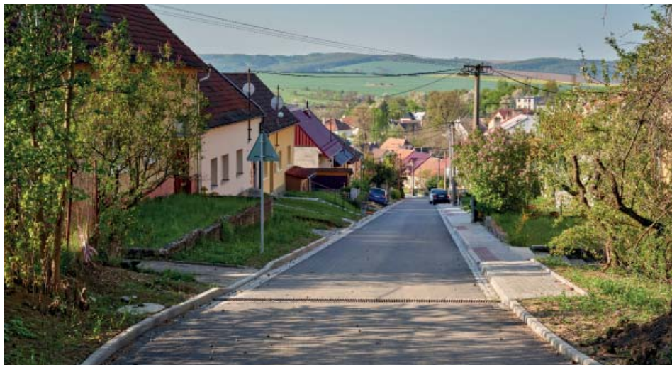
Nová komunikace a chodníky v části obce Drahy
