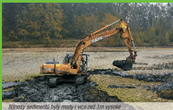
Pro odvodnění sedimentů byla prohloubena odvodňovací strouha
