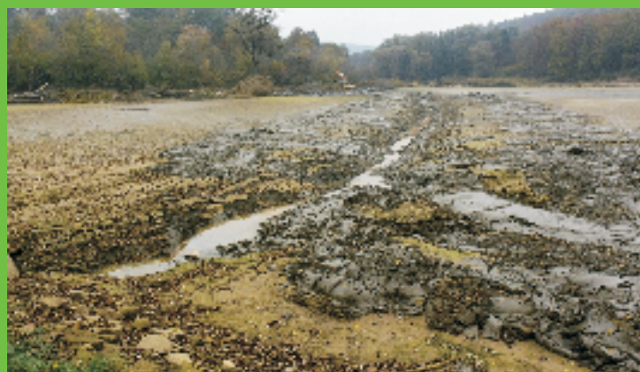
Pro odvodnění sedimentů byla prohloubena odvodňovací strouha
