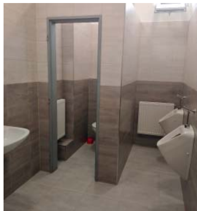
Zrekonstruované WC na pálenici
