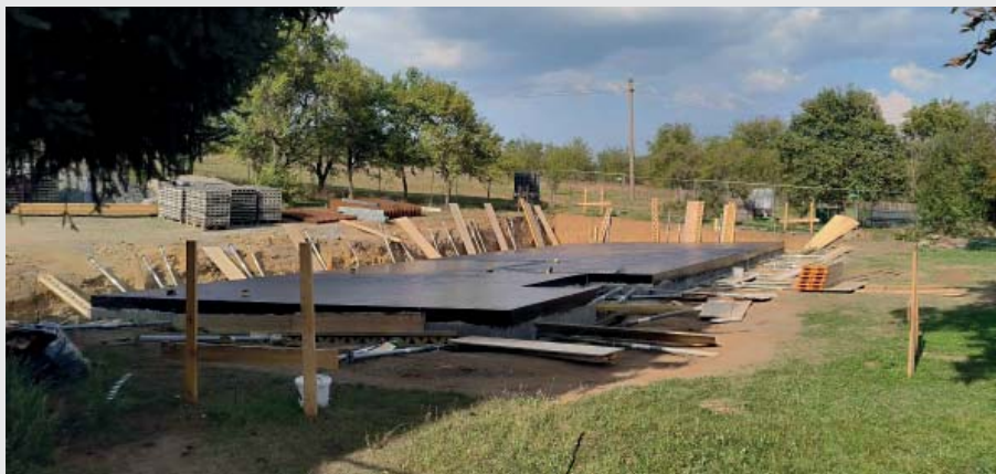
Výstavba objektu dětské skupiny v areálu MŠ
