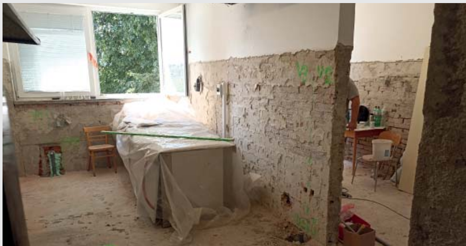
Rekonstrukce kuchyně v MŠ
