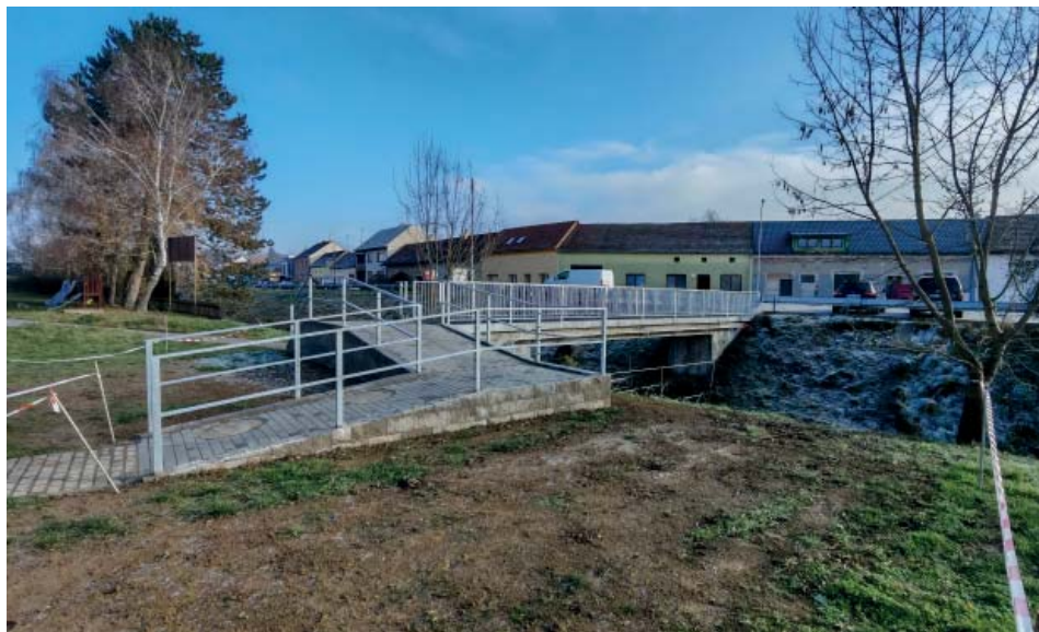
Zpevněná plocha Váha a lávka přes potok Březnici
