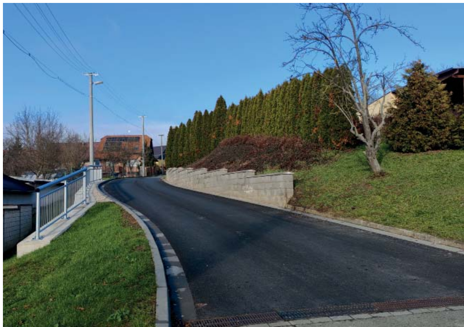
Stabilizace svahu u místní komunikace mezi spodními a horními Šraňkami
