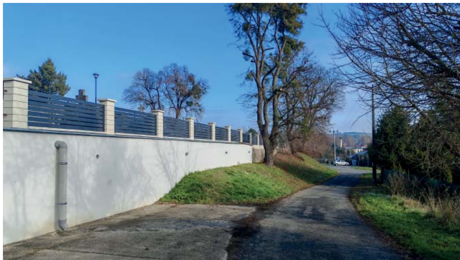
První hotové pole nové hřbitovné zdi
