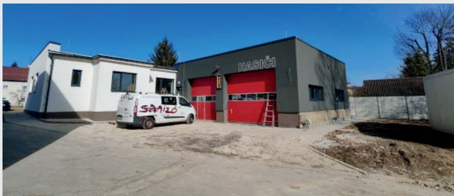
Dokončení rekonstrukce hasičské zbrojnice
