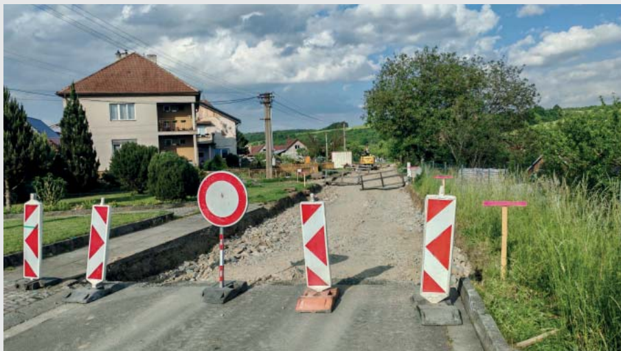
Rekonstrukce místní komunikace a chodníku Úlehla směr k MŠ byla zahájena
